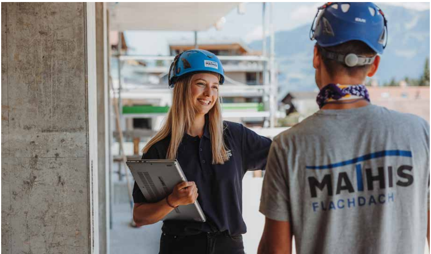
Natascha Mathis bespricht sich auf der Baustelle mit einem Flachdachmonteur.
